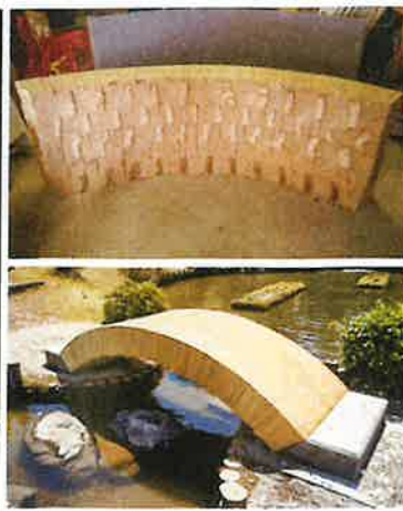
地元飲食店より提供を受けた竹の割り箸(約7万本)で作られた橋「日本箸」。完成から10年が経った今でも安全に渡ることができる
