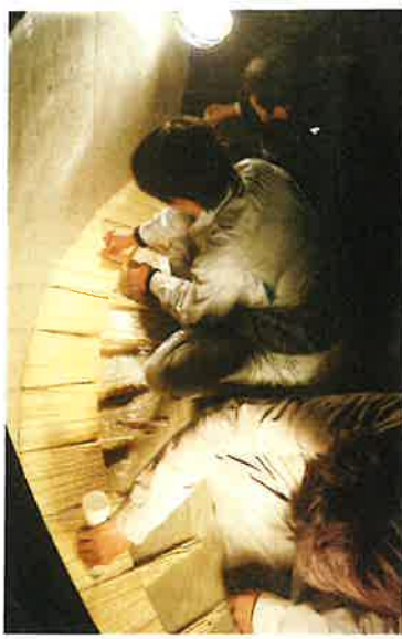
地元飲食店より提供を受けた竹の割り箸(約7万本)で作られた橋「日本箸」。完成から10年が経った今でも安全に渡ることができる
